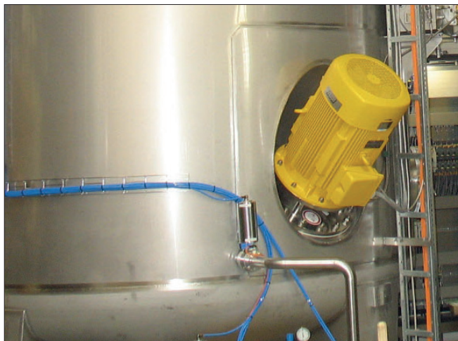
Jetstråleblandare kan med fördel placeras 45 gr in i tanksidan.
